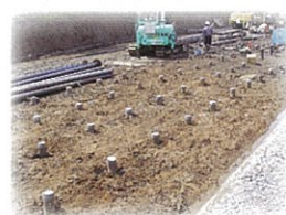
施工中の蓄熱専用杭
