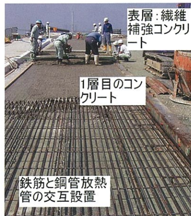
放熱管を浅く埋め wet on wet で施工中
