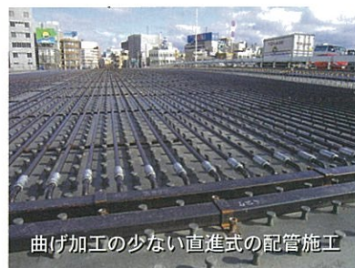
放熱管を浅く埋め wet on wet で施工中
