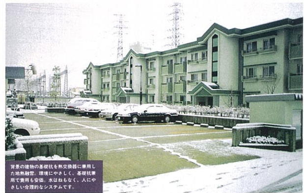
福井市「福井県立大学職員住宅 駐車場融雪」融雪面積：400㎡ 杭：PHC打撃工法48本φ400杭兼用 施工：'91～'92年
