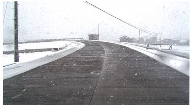
福井県坂井市「清永橋 橋面融雪・凍結対策」融雪面積：1810㎡ 杭：鋼管つばさねじ込み36本φ800杭兼用 施工：'01～'06年
