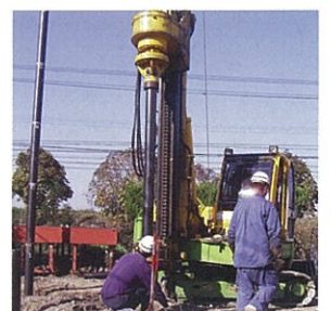
低振動・低騒音の回転圧入式で熱交換杭を施工中
