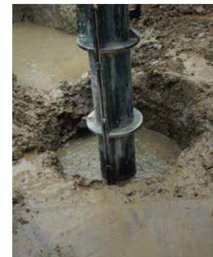
①掘削孔に装置挿入
