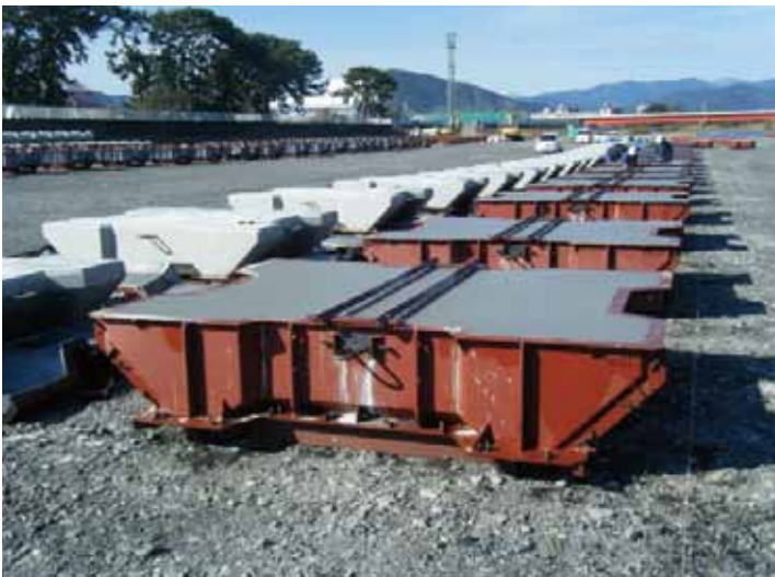
平成25年度安倍川下川原堤防補強工事
