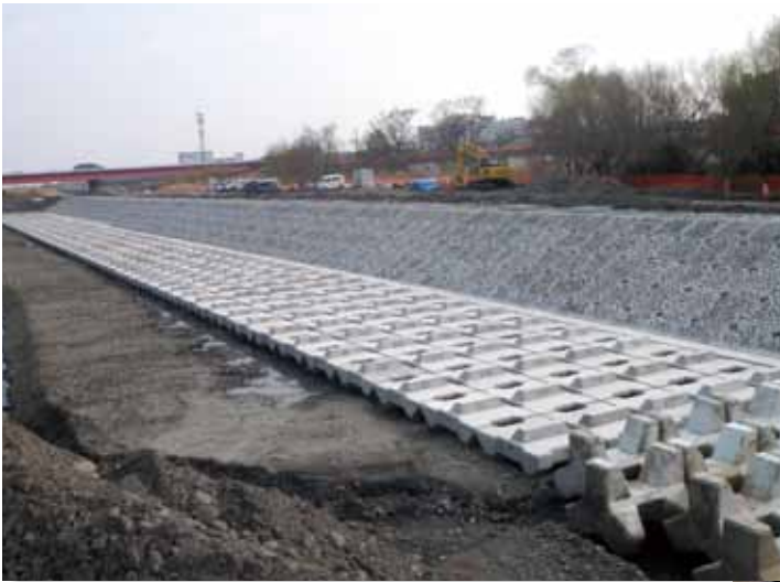
平成25年度安倍川下川原低水護岸工事
